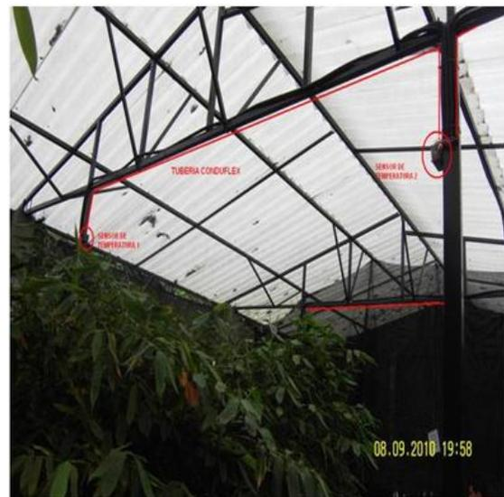
Figura 8. Distribución de sensores en el interior del invernadero.
