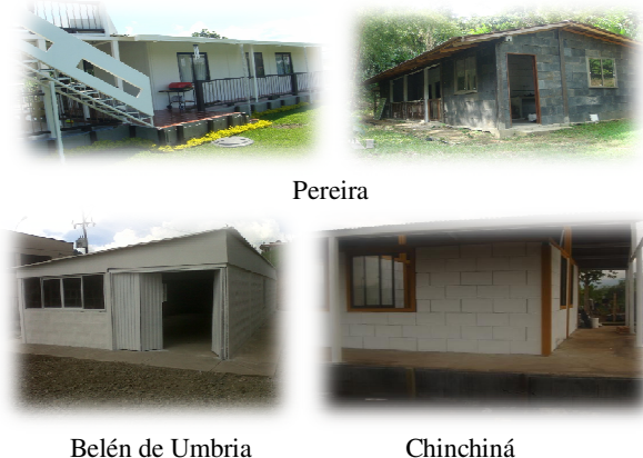
Figura 14. Casa fabricadas con ladrillo plástico
