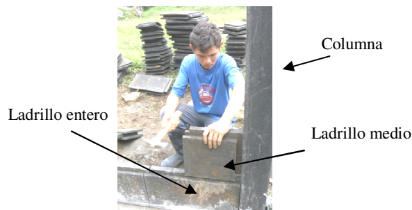
Figura 6. Ensamble de ladrillos en traslape y fijación a columna
