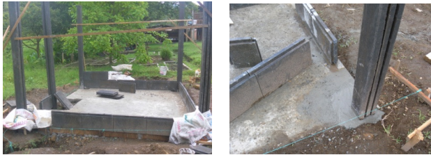
Figura 5. Placa base y columnas cimentadas
