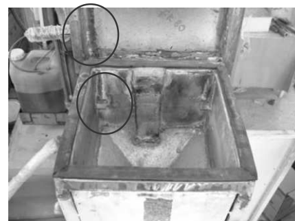
Figura 3. Recipiente de cloruro de metileno, los círculos muestran las imperfecciones que ocasionan fugas
