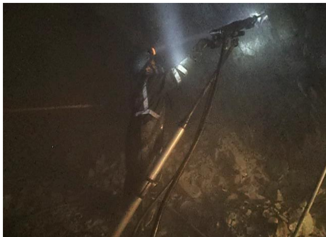
Fig. 3. Tarea perforación de frente con máquina Jack-Leg. Fuente: elaboración propia.
