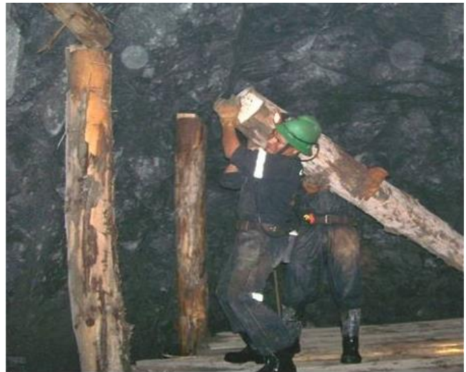
Fig. 2. Tarea sostenimiento con cuadros de madera. Fuente: elaboración propia.
