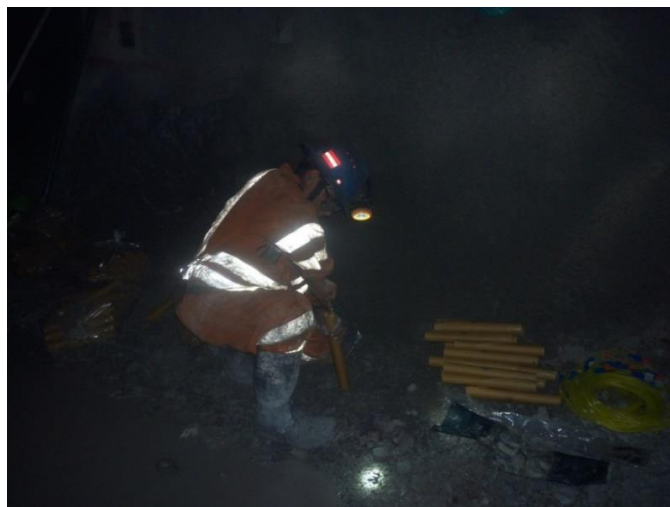
Fig. 4. Minero preparando la carga explosiva para la voladura. Fuente: elaboración propia.
