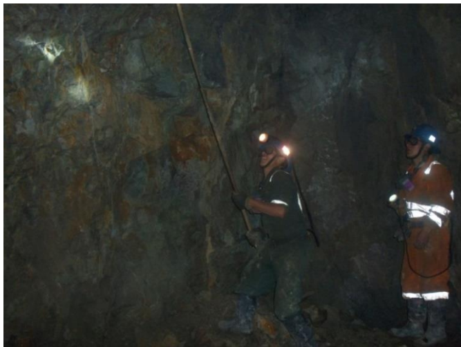
Fig. 1. Tarea desatado de rocas. Fuente: elaboración propia.
