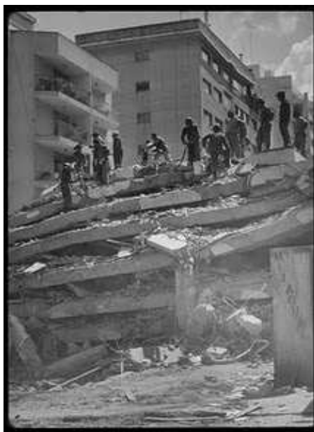
Figura 9. Daños en Armenia sismo de 1.999
