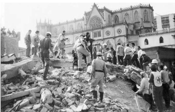
Figura 8. Daños en Pereira Sismo de 1.995
