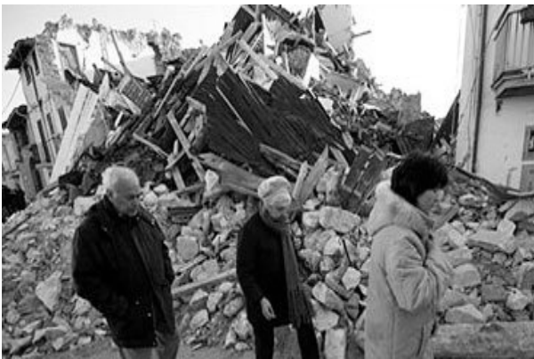
Figura 7. Daños en Popayán sismo de 1.983
