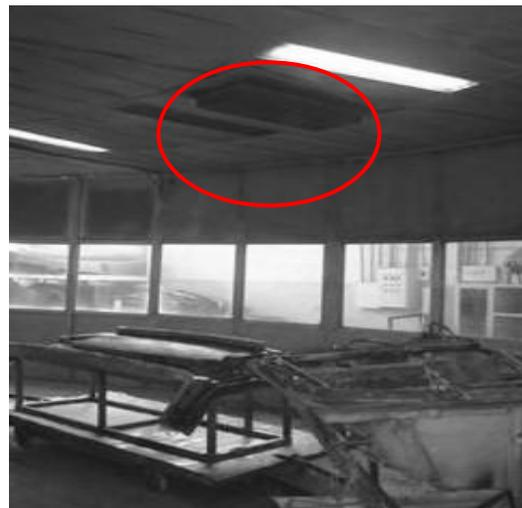
Figura 1. Boquilla de combustión para curado de piezas
