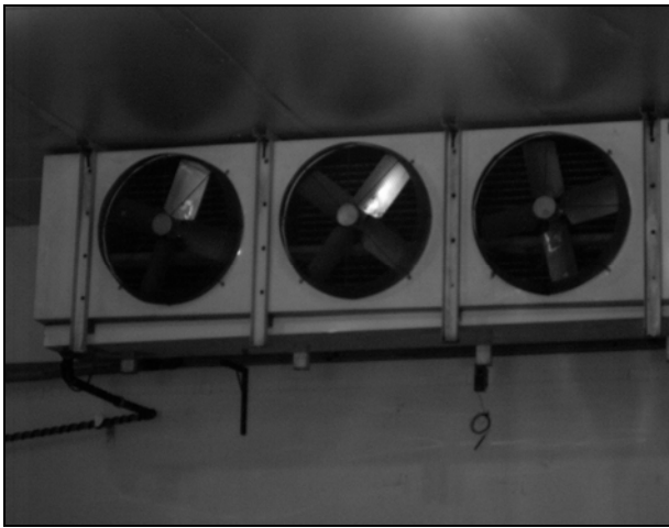
Figura 3. Evaporador Máquina 5
