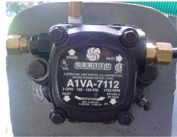
Figura 1 Bomba del quemador
