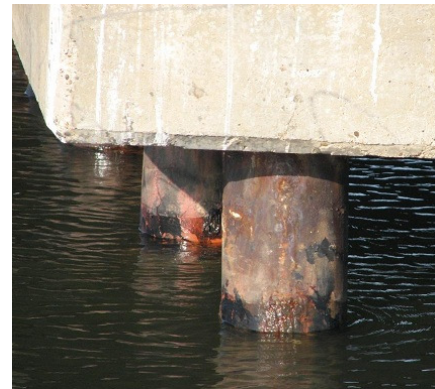
Figura 9. Estado inicial de los pilotes
