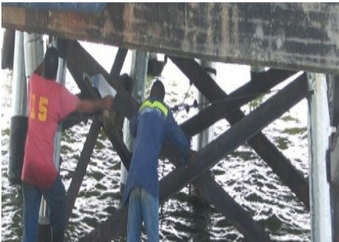
Figura 7. Aplicación de Zinc Tape®
